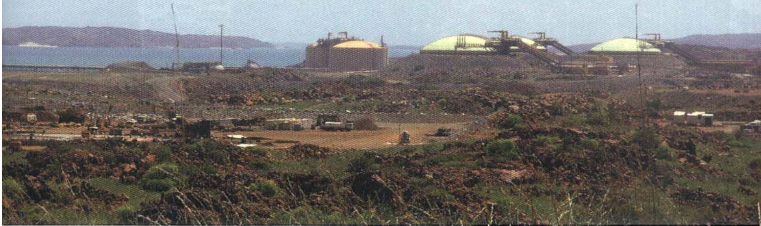
■ An der Westküste der Halbinsel errichtet die Woodside Pluto LNG zurzeit ein neues Kraftwerk – die Behälter im Hintergrund sind Teil der in den 1980er Jahren gebauten Joint-Venture-LNG
